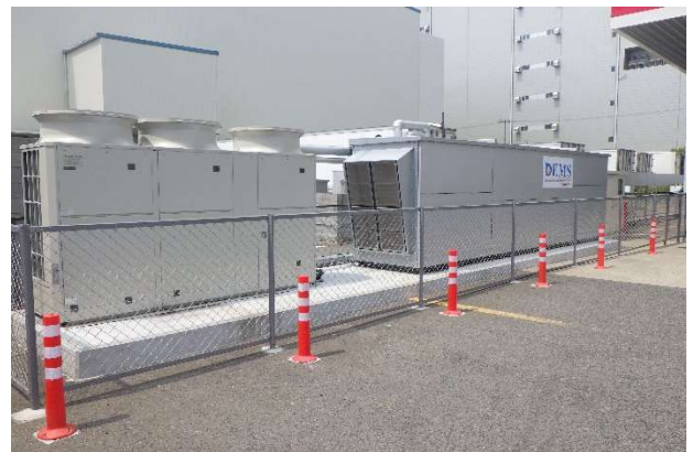
写真3 DEMS 設置状態
