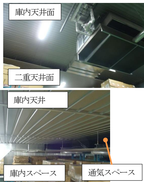
写真2 ゆらぎシステム設置状況
